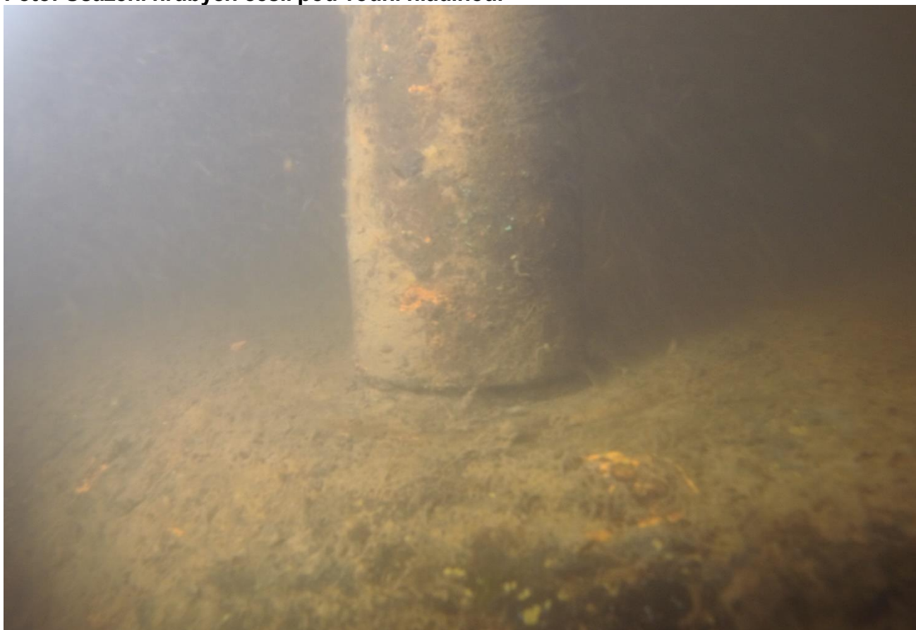
Foto: Usazení hrubých česlí pod vodní hladinou.
