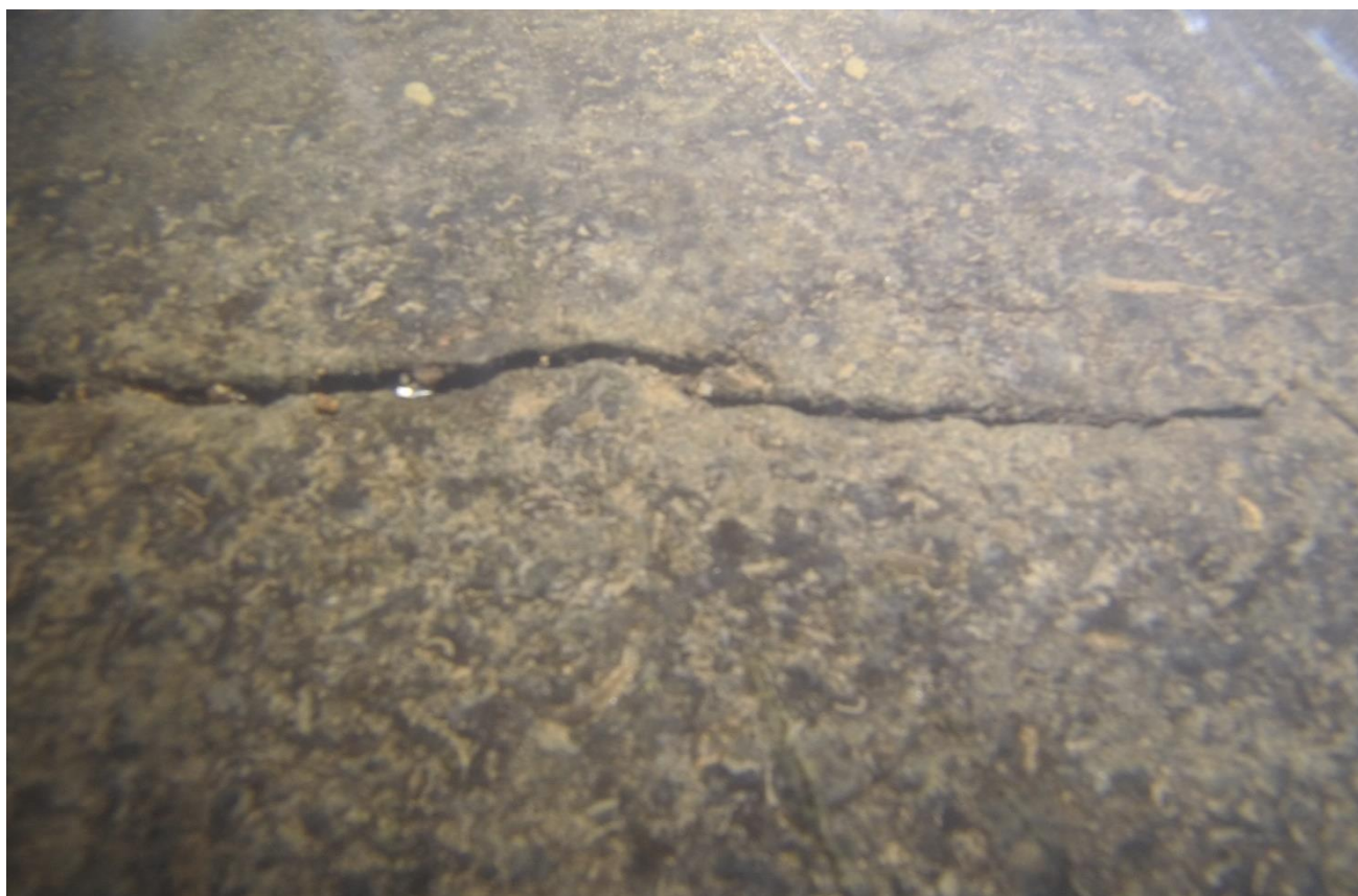
Foto: Odhalená pracovní spára.
