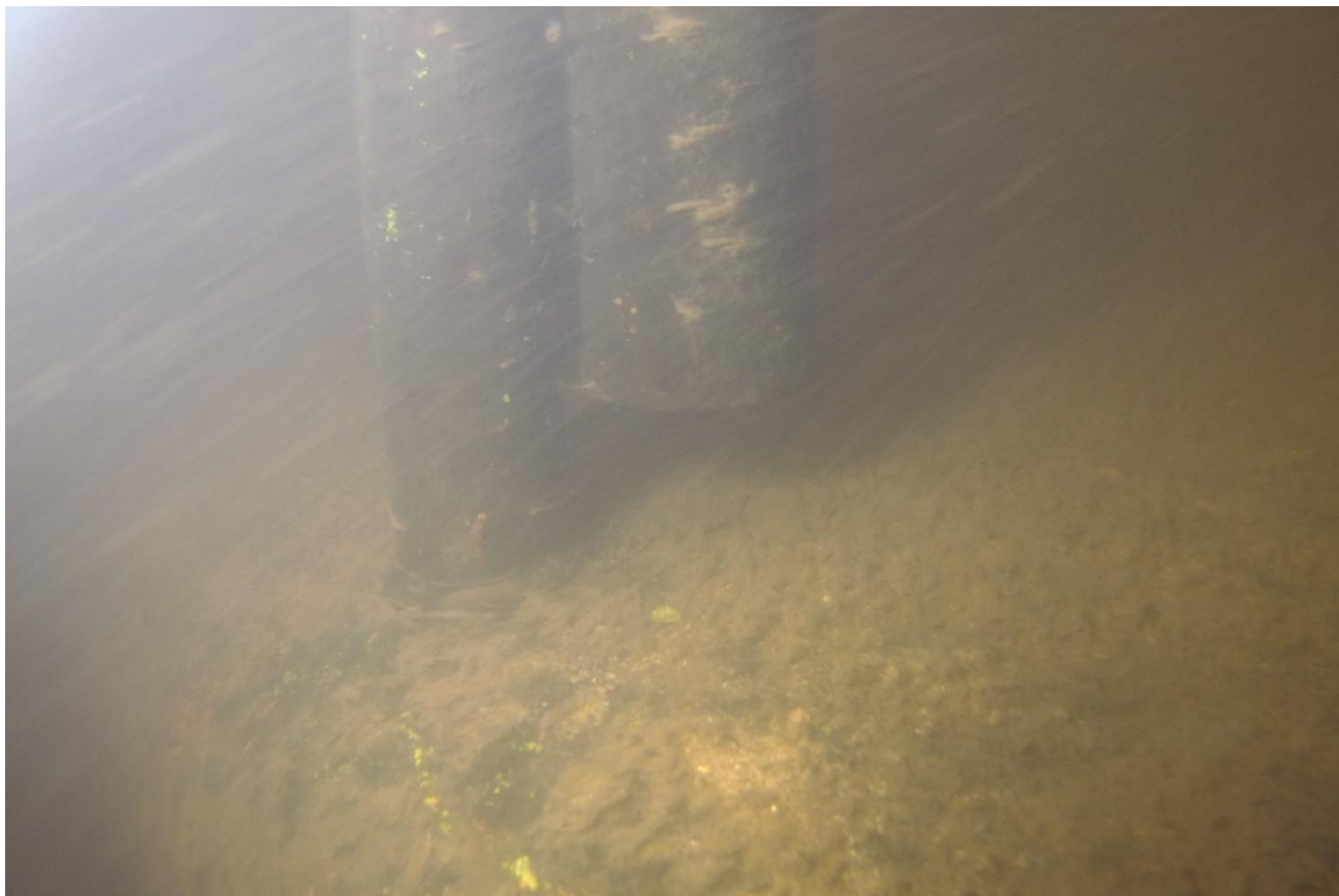
Foto: Usazení hrubých česlí pod vodní hladinou.
