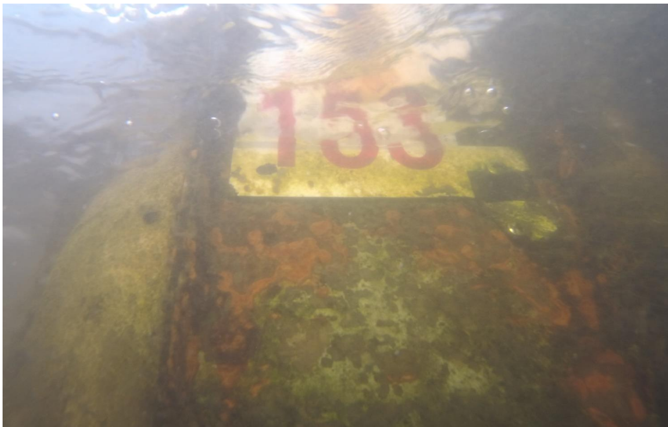
Foto: Vodočetná lať na pilíři pravého břehu, končí těsně pod vodní hladinou.
