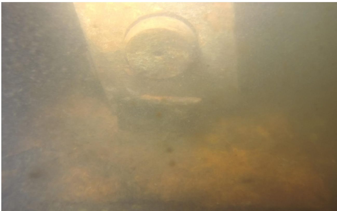
Foto: Usazení slupice a začepování do oka pro slupici.
