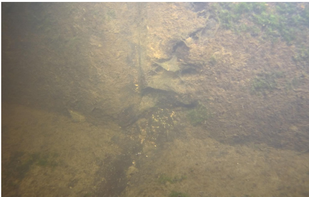
Foto: Odhalená pracovní spára.
